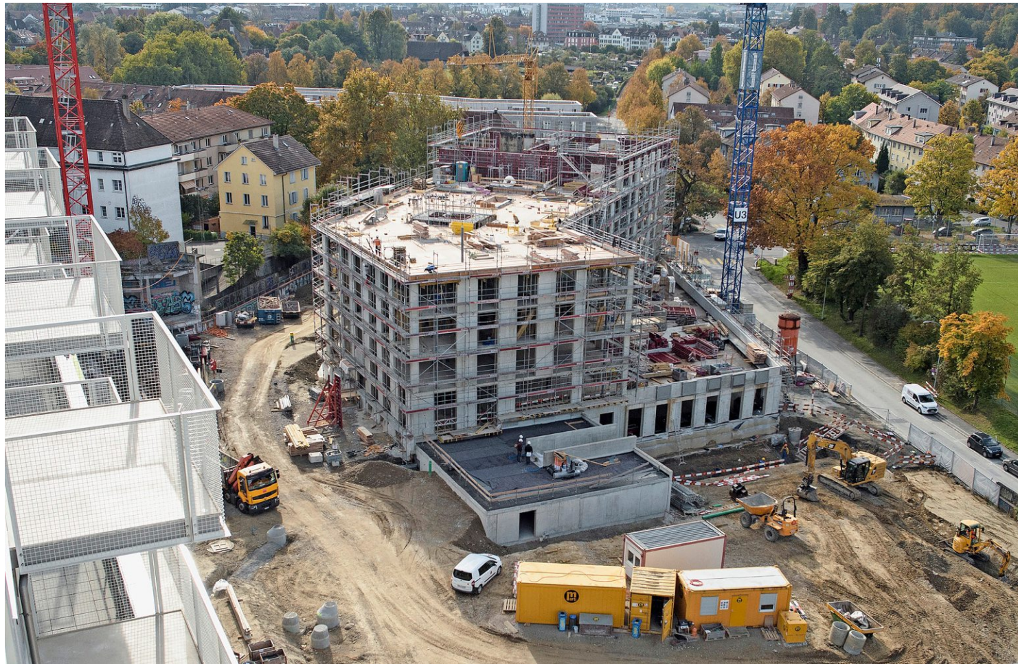
Blick vom ehemaligen Tobler-Lagerhaus auf die Baustelle und den Rohbau der Baugenossenschaft Brünen-Eichholz. Foto: Franziska Rothenbühler
