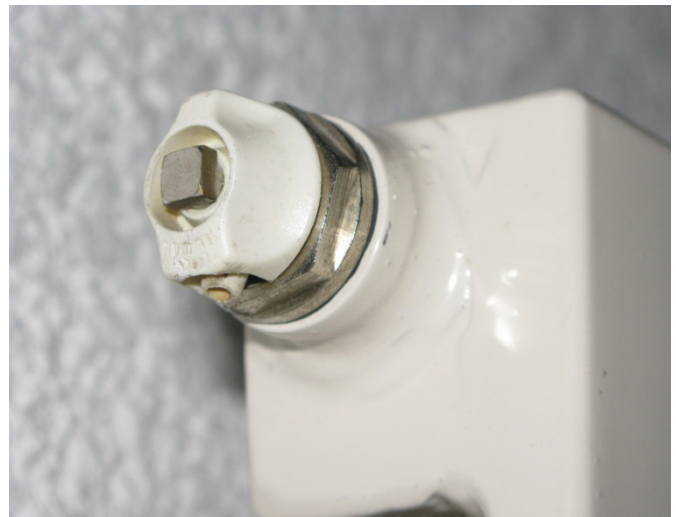
Entlüftungsventil am Heizkörper
