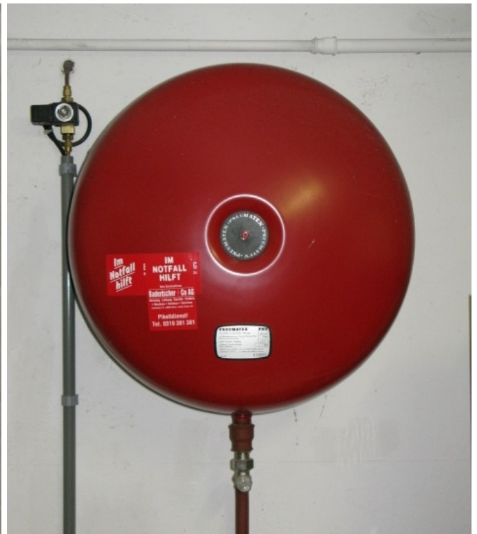
Druckausdehnungsgefäß *Pneumatex*
