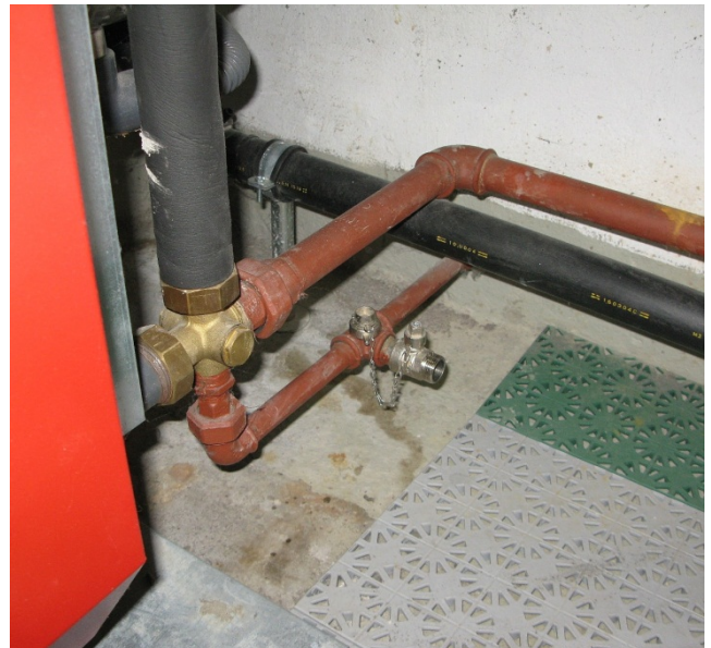
Der Füllstutzen befindet sich meist hinter dem Heizkessel
