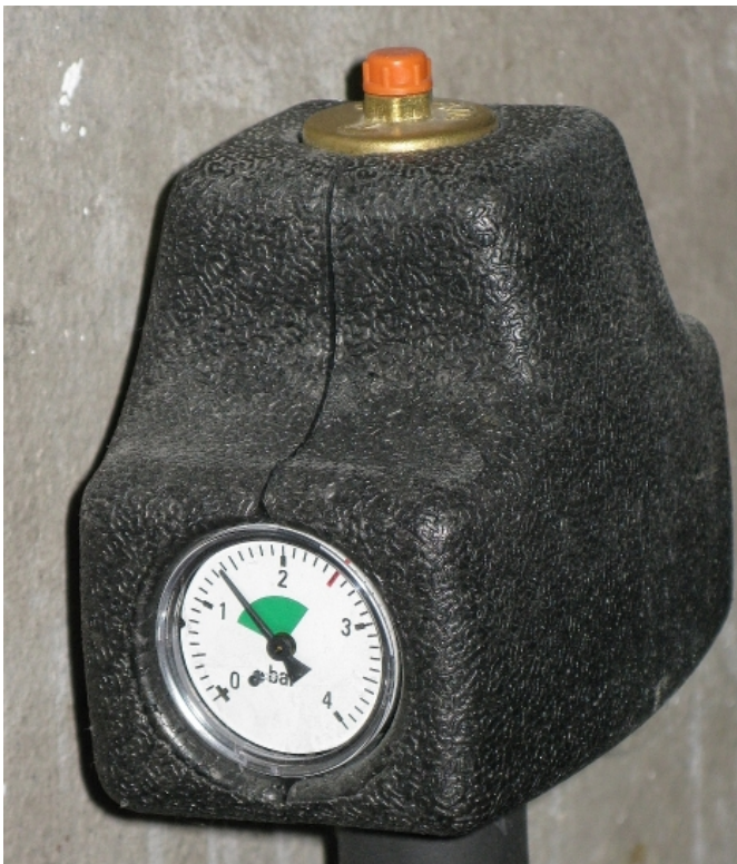
Manometer: Zeigt den Wasserdruck an
