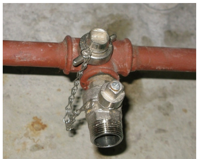
\frac{1}{4} Drehung gegen Uhrzeigersinn zum Öffnen des Ventils
