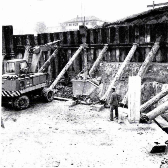
Baugrube Häberlimatte mit Spundwand
