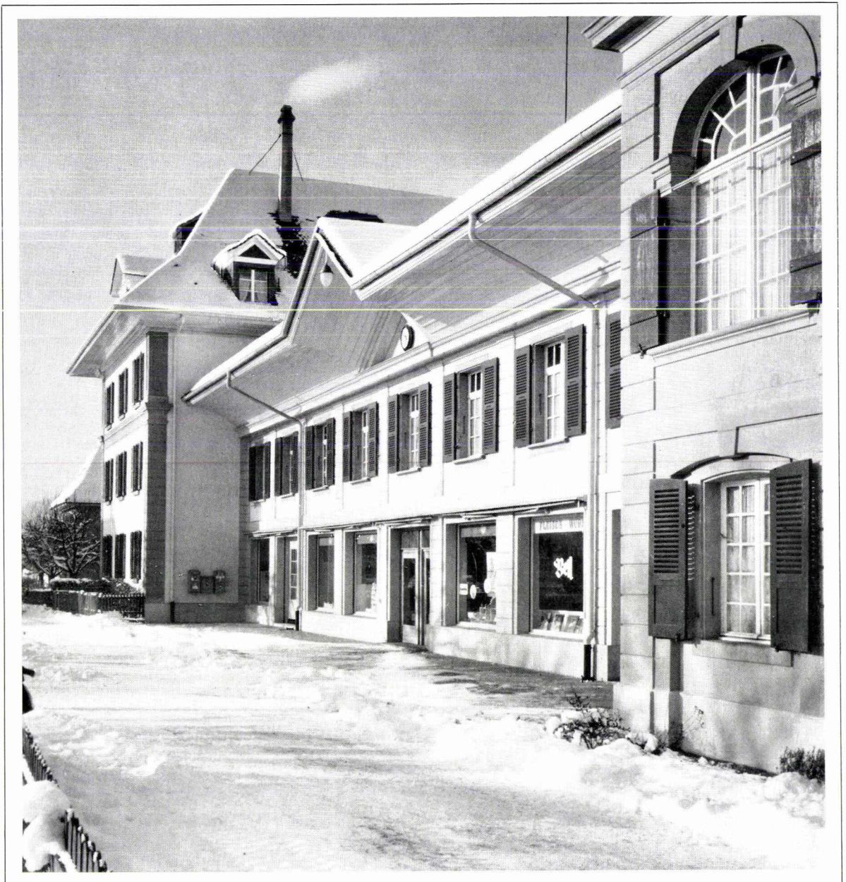
Das Geschäftshaus zwischen Herrschaftshaus und angebautem Südflügel
