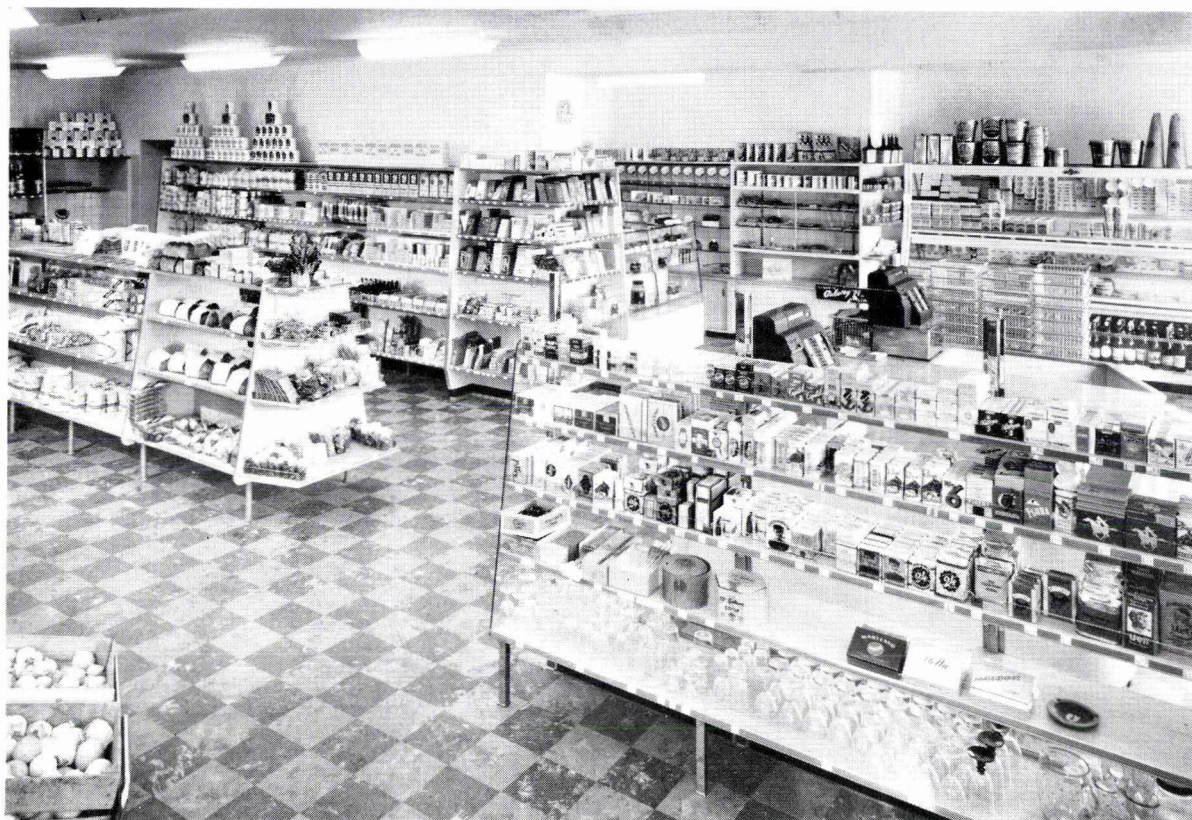
Die COOP-Filiale nach dem Umbau 1951
