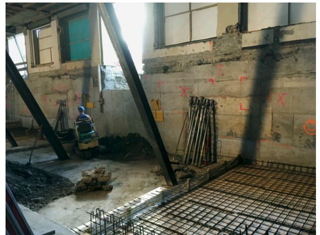
Abb. 34: Aushubarbeiten im Untergeschoss: Hier entstehen Archivräume sowie Dusche und WC.
