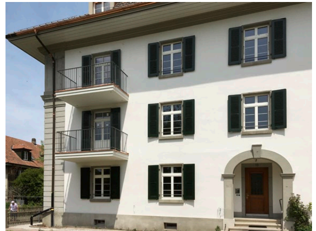
Abb. 31: Der denkgeschützte Windfang durfte nicht erweitert werden.
