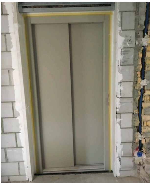
Abb. 30: Der neue Lift findet im ehemaligen Lichtschacht Platz.
