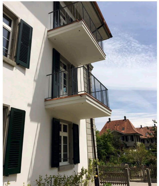
Abb. 29: Die erweiterten Balkon am Hauensteinweg 16.
