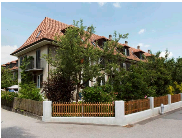
Abb. 9/10: Die mehrgeschossigen Einfamilienhäuser mit den schmalen Treppen sind nicht geeignet für ältere Menschen.
