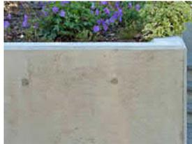
Ortbeton, grau, ohne Zusatzstoffe mit aufgerauter Oberfläche (verputzt, abgerieben, gestrahlt o.a)
