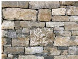
Berner Jurakalkstein oder Sandstein mit einer Schichtstärke von maximal 20-40cm in Trockensteinmauerwerk
