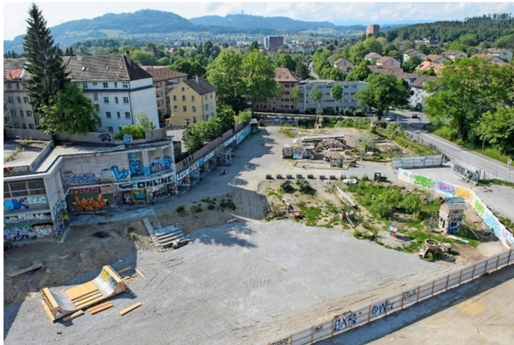
Noch ist das Warmbächli-Areal eine Brache. Mit der Überbauung ändert sich auch der Name zu Siedlung Holliger. Bild: Raphael Moser
