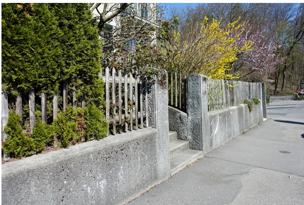
Abbildung 12: Erhöhte Gartensituation mit Sockelmauer und Zugangstreppe, W+B 2017
