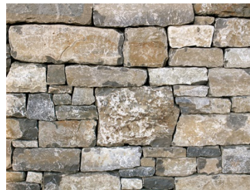
Berner Jurakalkstein oder Berner Sandstein mit einer Schichtstärke von maximal 20-40cm in der Bauweise «Trockensteinmauerwerk»
