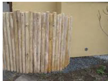
Beton- und Holzpalisaden
