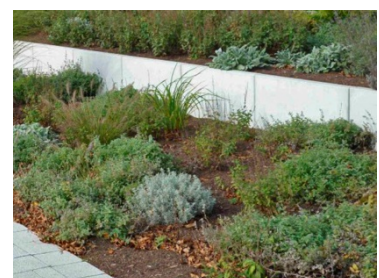
Winkelemente aus Beton, grau, scharfkantig und in möglichst langen Einzelementen von ca. 2m
