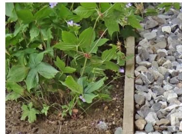
Bodenbündig eingebaute Holzlatten
