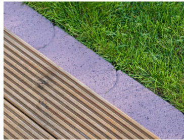
Eingefärbte Betonstellriemen und Abschlusssteine
