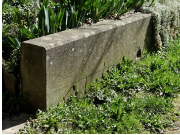
Ortbeton, grau, ohne Zusatzstoffe mit aufgerauhter Oberfläche (verputzt, abgerieben, gestrahlt o.a.)
