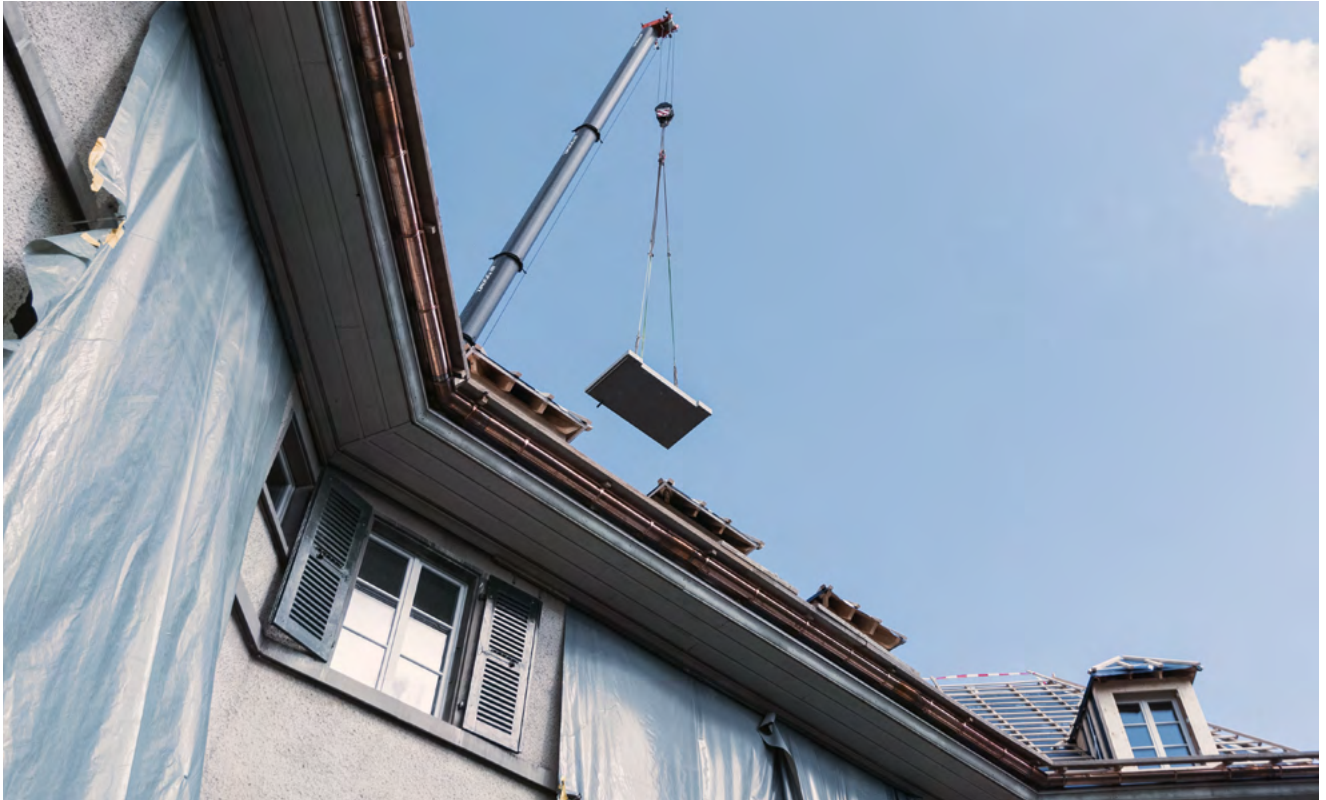
Die Nachbarschaft hatte Verständnis für die Bauarbeiten: Ein Pneukran hebt Balkonelemente.
