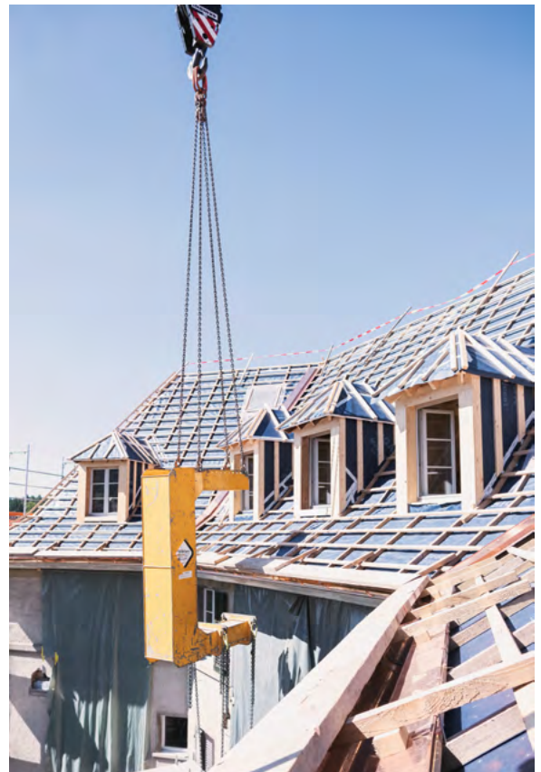
«Süder»: Bauarbeiten im Dachbereich.
